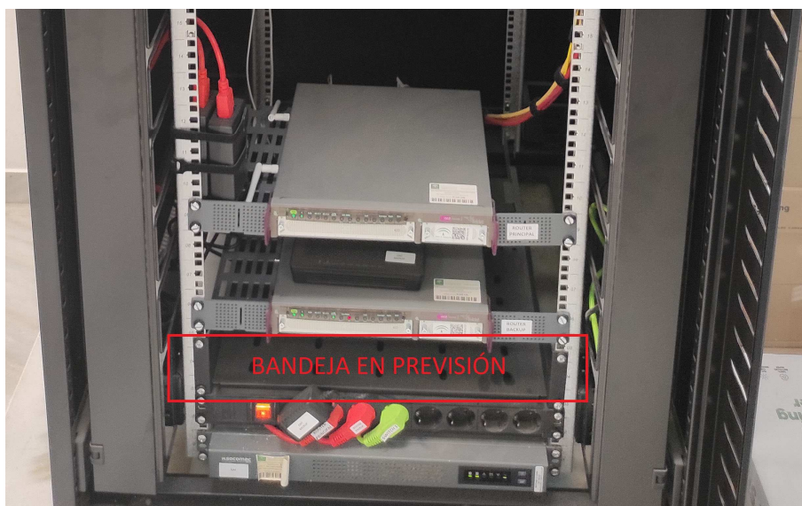
Ilustración 10. Bandeja inferior sobre regletas de corriente
