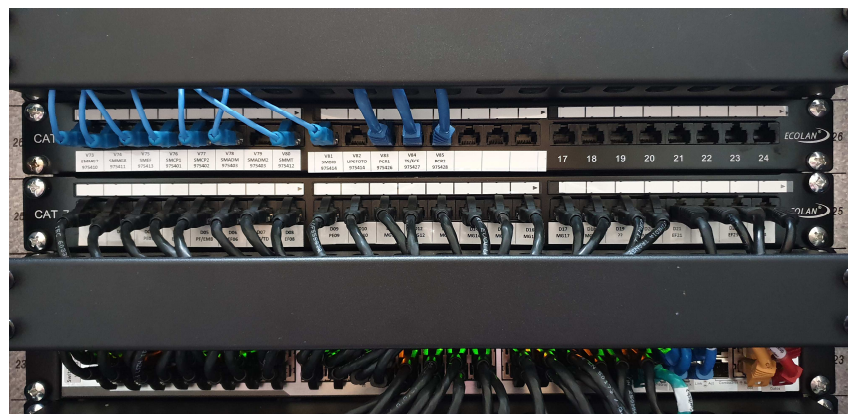
Ilustración 17. Uso de latiguillos de datos y de voz
