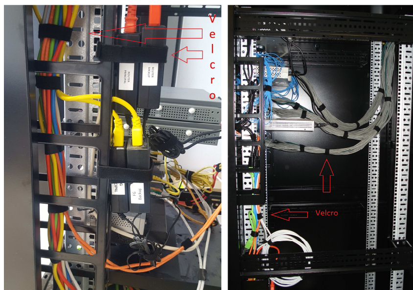
Ilustración 11. Sujeciones con velcro para los mazos de cables
