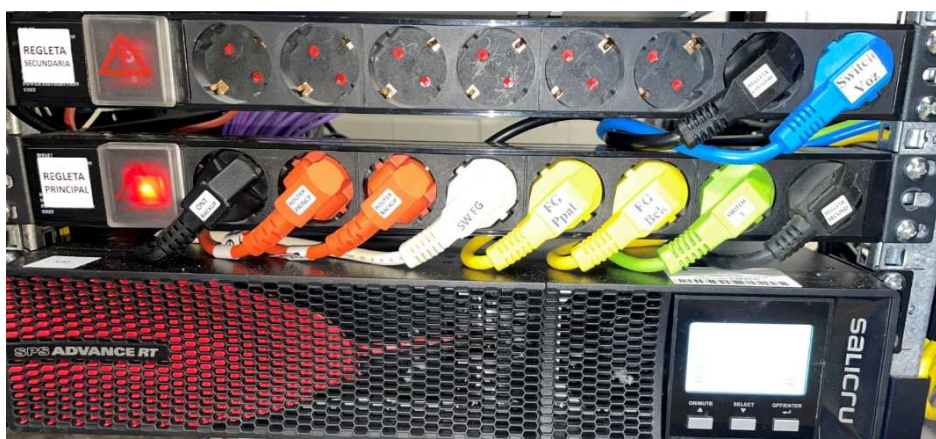
Ilustración 24. Ejemplo de configuración de regletas de corriente
