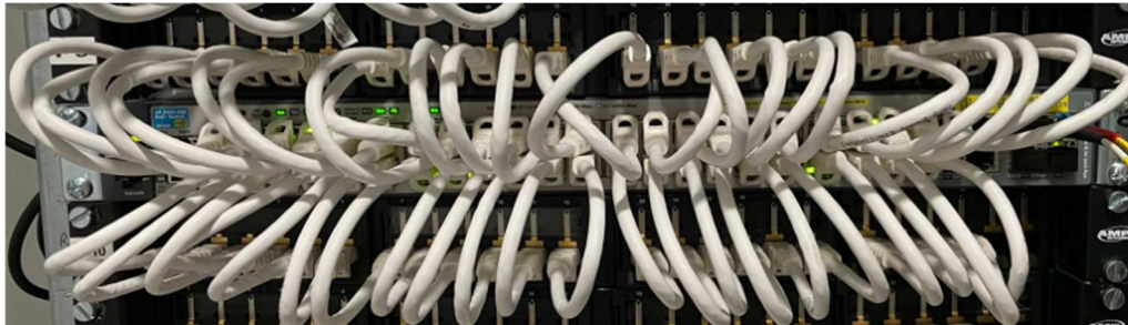
Ilustración 14. Tripleta parcheada
