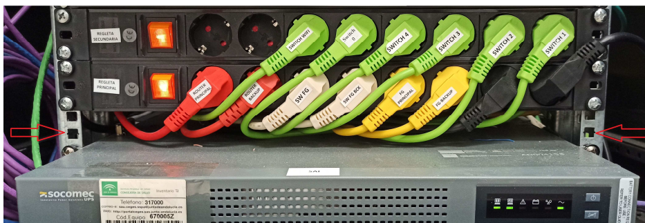
Ilustración 9. Espacio entre regletas y SAI para permitir el paso de los cables
