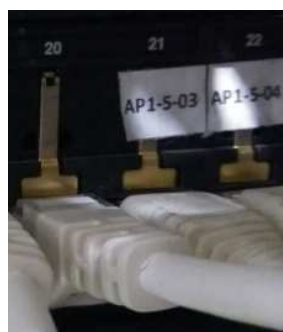
Ilustración 28. Etiquetado de puntos de acceso en panel de parcheo
